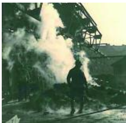
Eine sehr heiße Arbeit: Ein Arbeiter 1936 beim Ablöschen des Koks von Hand im Pradler Gaswerk.
